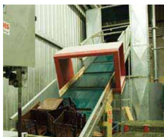
Opération de broyage
